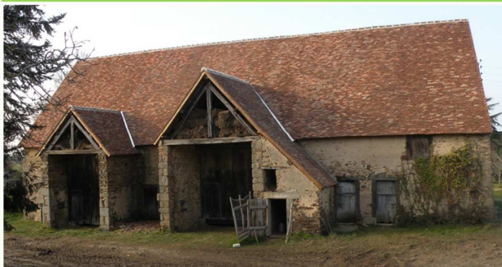
Restauration d'une grange à double porteaux (Chassignolles) 6 700 €
